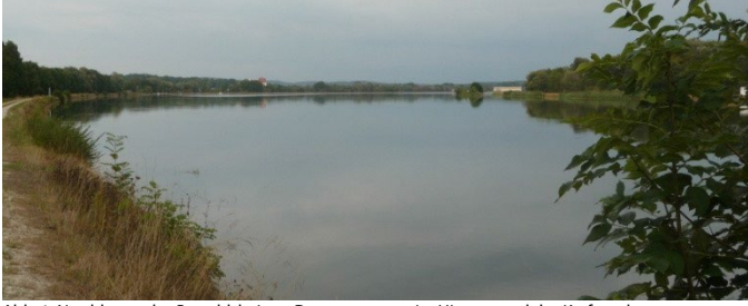
Abb. 1: Norddamm des Bertoldsheimer Donaustausees; im Hintergrund das Kraftwerk.
