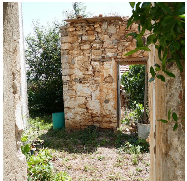
Abb. 9 – Ruine in Kastro.
