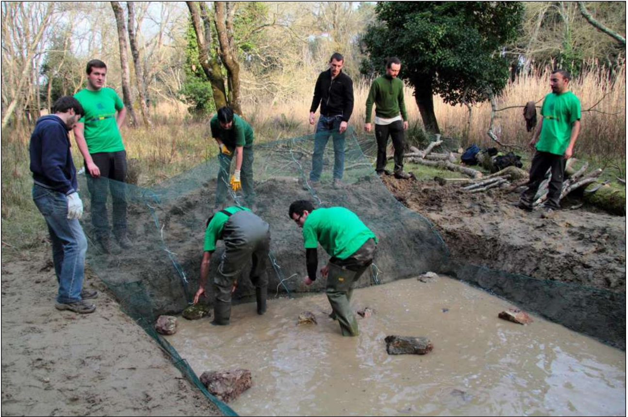
Figura 5.49 Fasi di fissaggio della rete protettiva.
