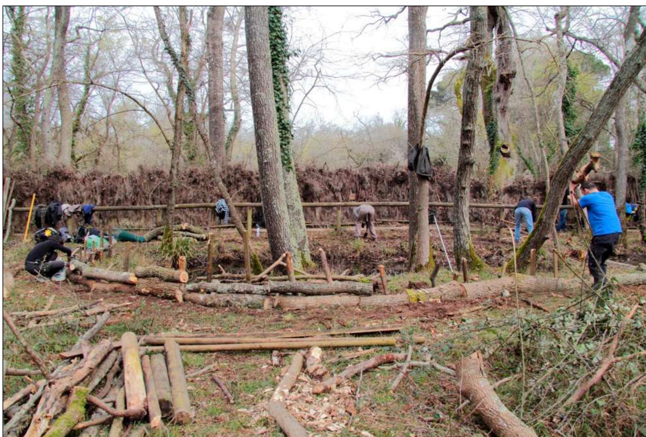
Figura 5.43 La disposizione dei primi tronchi di protezione attorno allo stagno.
