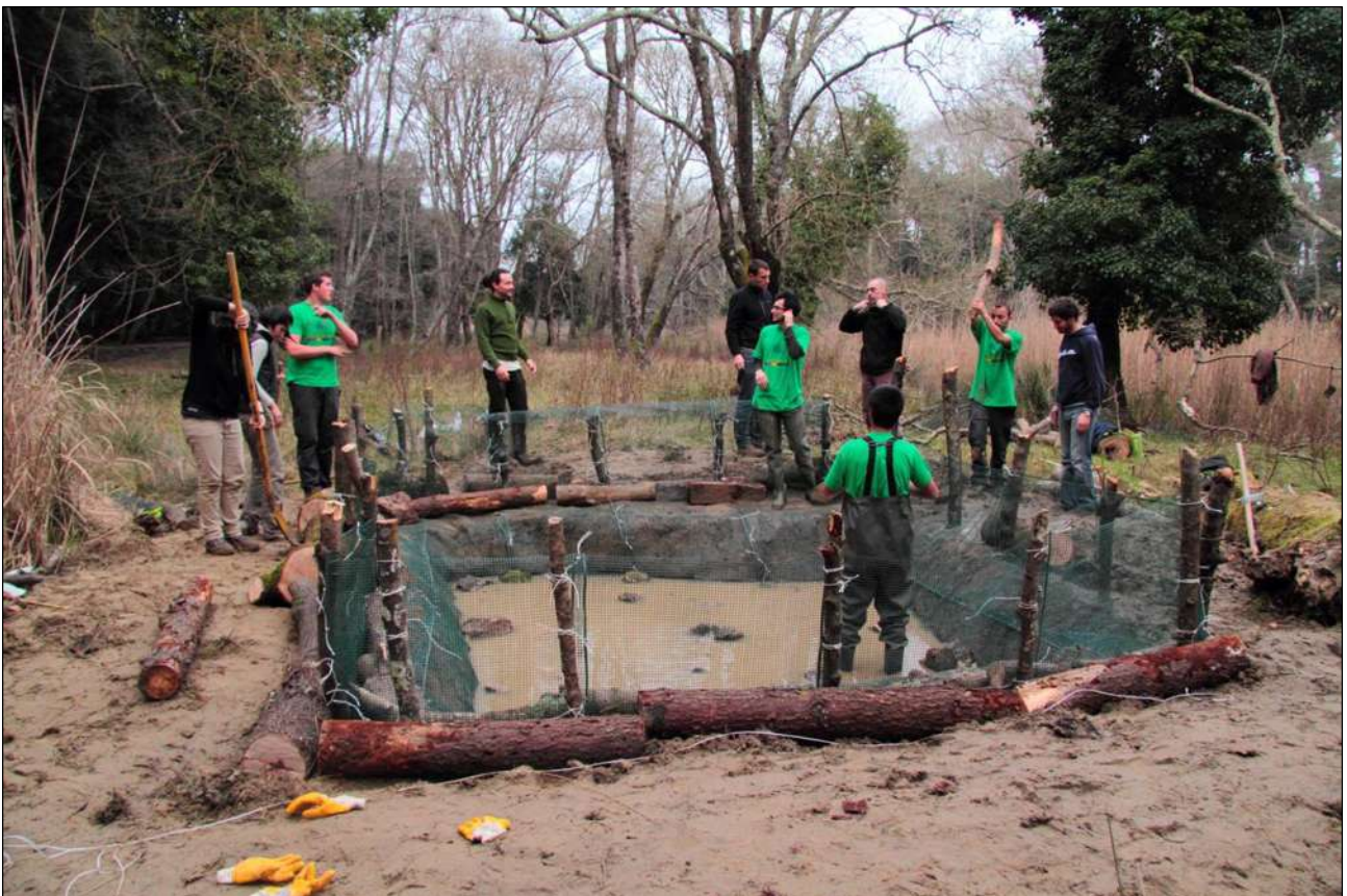
Figura 5.50 Fase di stabilizzazione dei tronchi all'interno del fossato.
