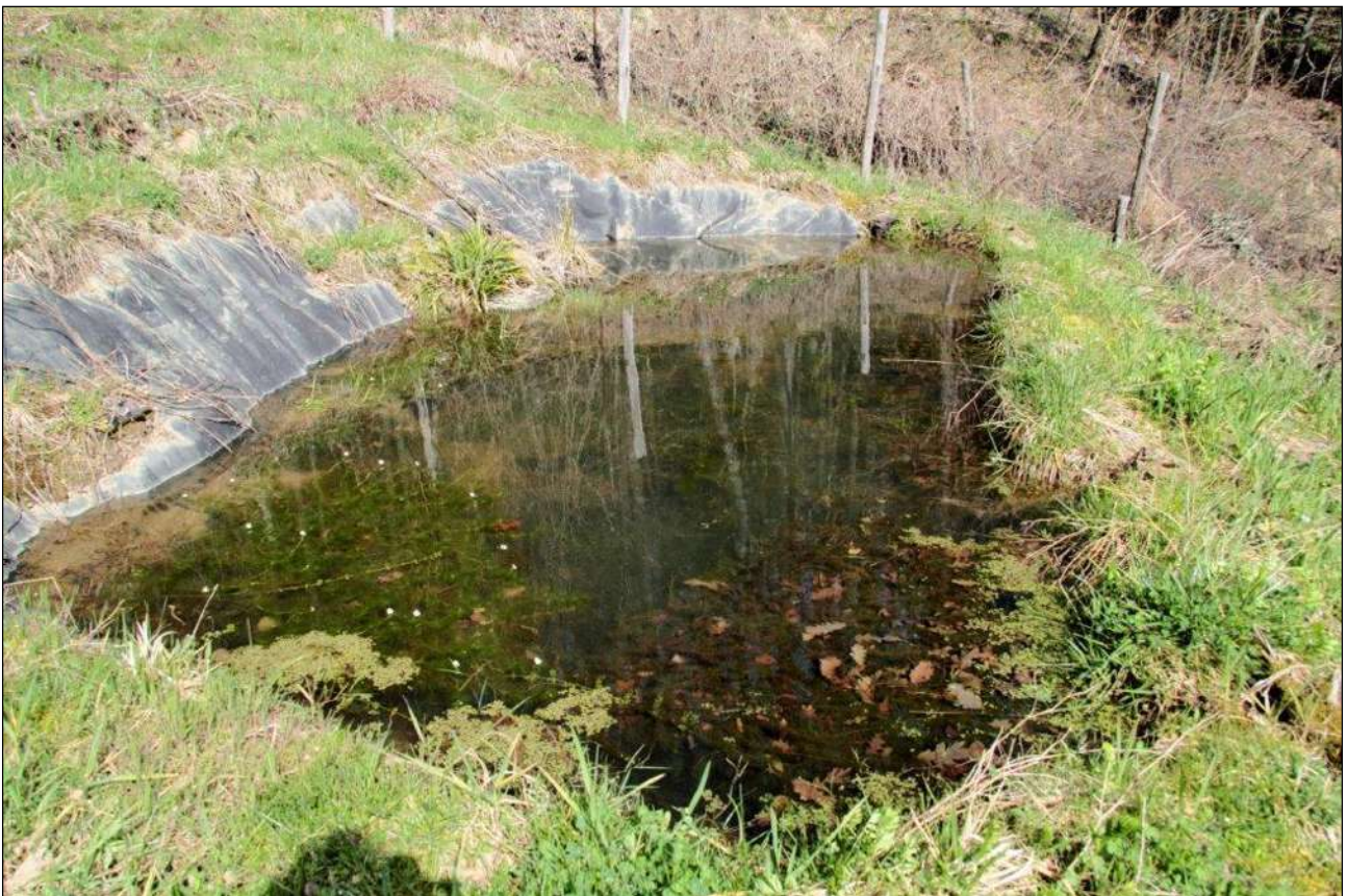
Figura 5.30 Lo stagno impermeabilizzato, ricco di vegetazione acquatica durante il mese di maggio 2013.
