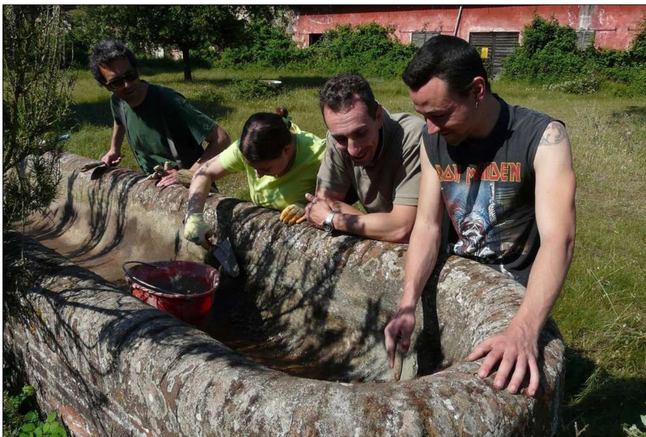
Figura 5.55 Applicazione del cemento impermeabilizzante sulle pareti laterali dell'abbeveratoio.
