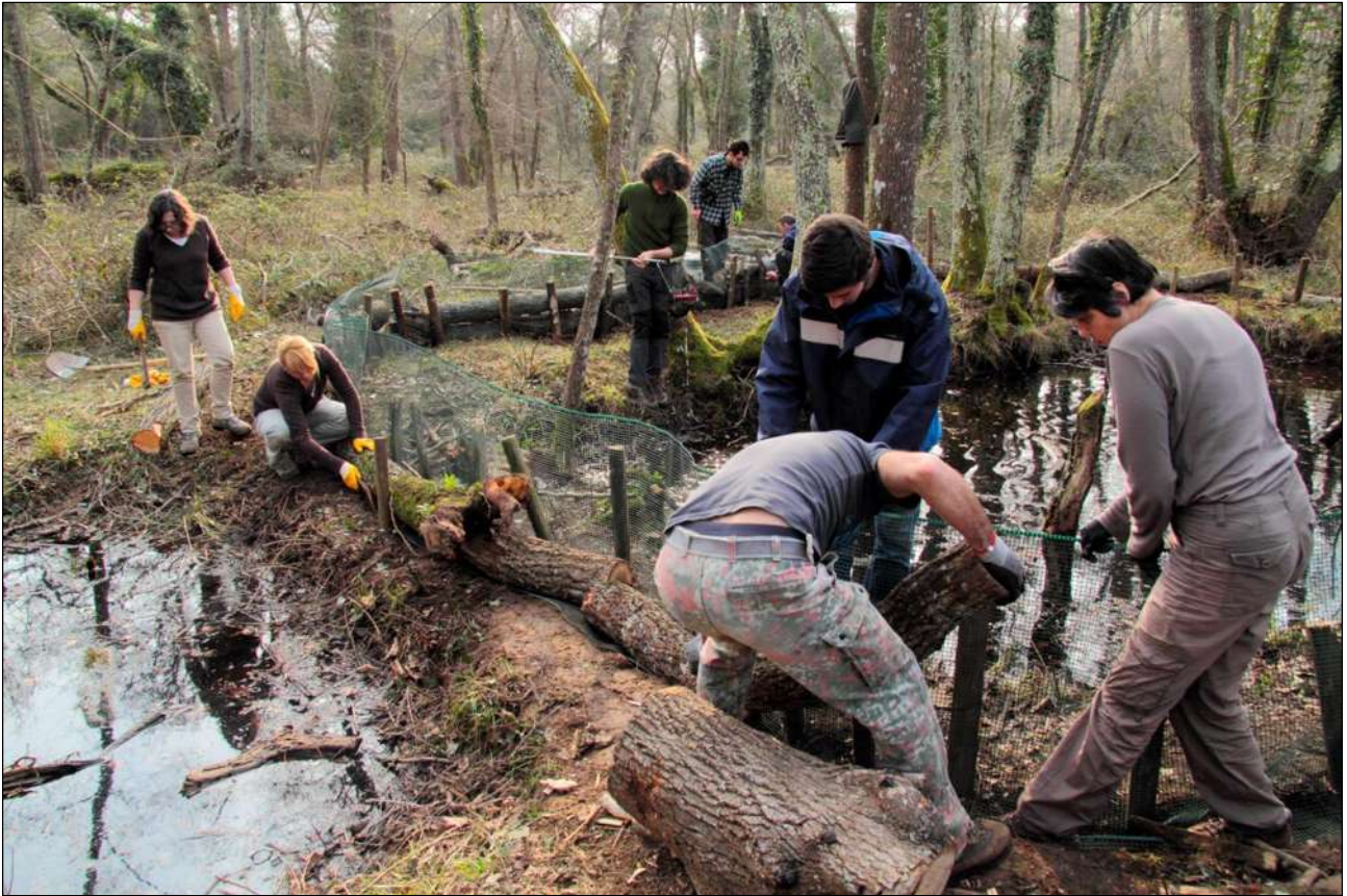
Figura 5.44 Alcune fasi dell'interramento e fissaggio della rete protettiva.
