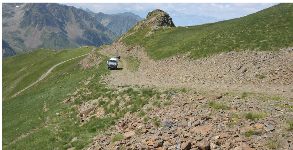
La piste « Panoramic » de la station du Tourmalet, dont l'élargissement mettait en péril la population d'I. bonnali qui s'y était installée. Des mesures d'évitements (ajustement de l'emprise travaux/évitement d'éboulis favorables) et de réductions/compensations ont été également prévues.
