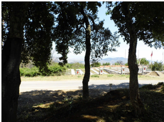
Figure 27. Réservoir d'eau, Chlef.
