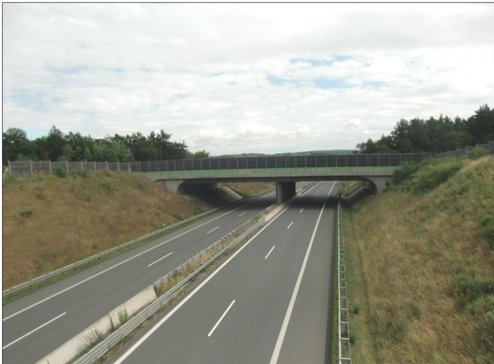
Abbildung 3: Grünbrücke über die B6n (Bauwerksnummer 48.1)
