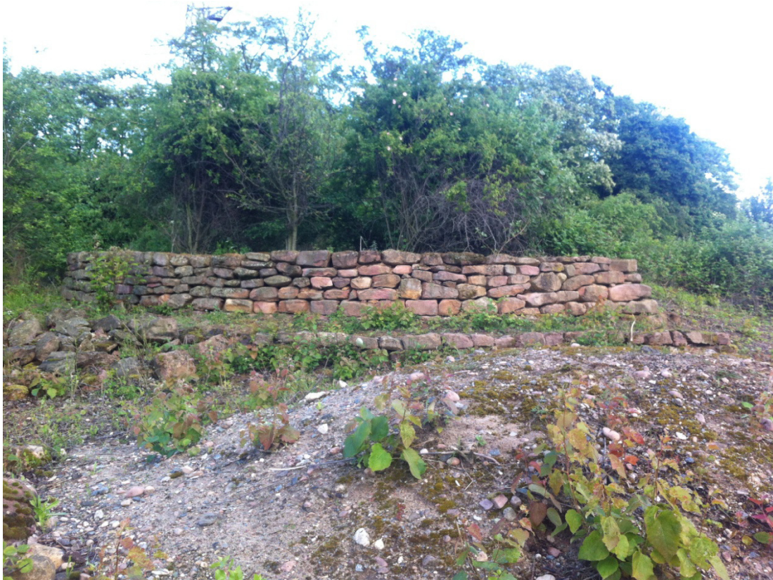
Gebiet Weilbach: Trockenmauer im Gebiet (Foto: Anna Pietsch)
