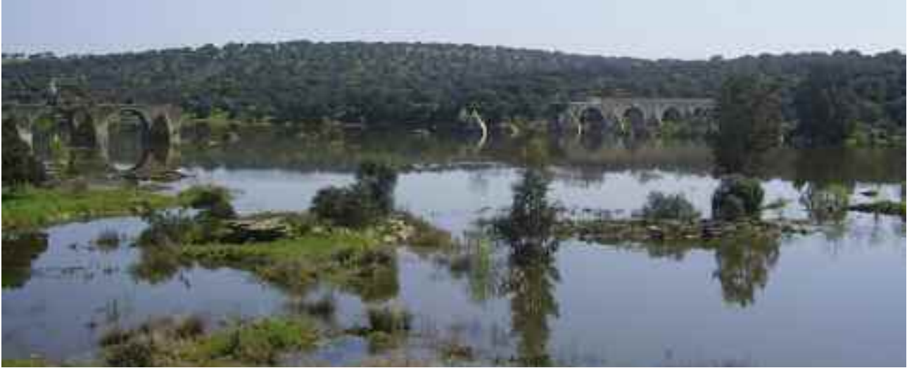
El fraile mantiene buenas poblaciones en el cauce principal del Guadiana. Puente Ajuda. Río Guadiana.
