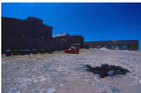
Figura 4. La creciente humanización que afecta a la cumbre de la Peña de Francia está contribuyendo a la rarefacción de la especie. Las nuevas construcciones se efectúan sobre zonas de roca o antiguos pretilos de piedra antaño habitados por la lagartija batueca. © Oscar Arribas.
